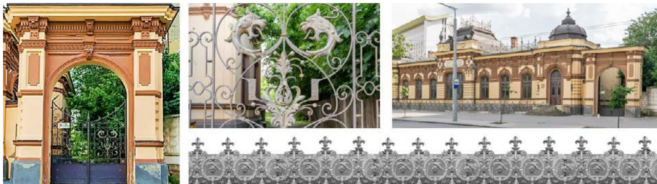
Imaginea 9. Element fațadă, Vila urbană Vladimir Herța – poarta, bordură forjată.
